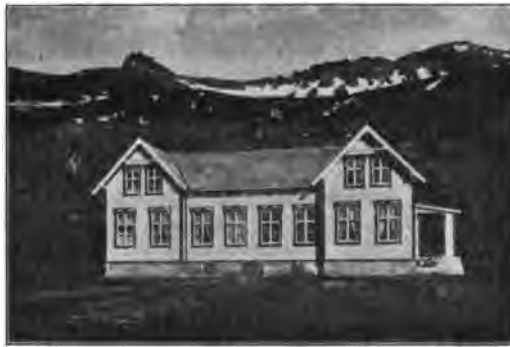
106. Krankenhaus in Seyðisfjörður.
